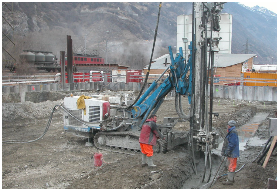
Abb. 1: Erstellung einer Jettingsäule
